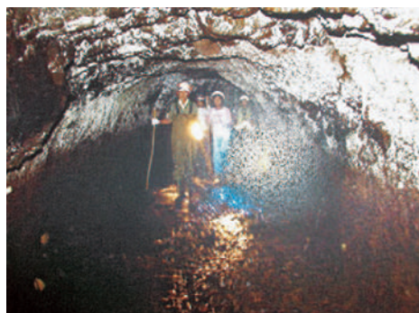
江戸時代に掘削された深良用水の手掘りトンネル
